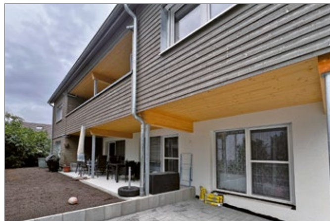
Nord- und Südseite des seriell sanierten Gebäudes mit zusätzlichen Gauben und erweiterten Balkonen und Terrassen
