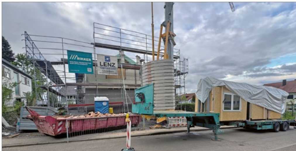
Baustelle mit angelieferten Wandelementen einschließlich vormontierter Fenster
