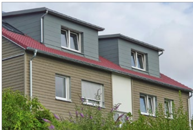
Nord- und Südseite des seriell sanierten Gebäudes mit zusätzlichen Gauben und erweiterten Balkonen und Terrassen
